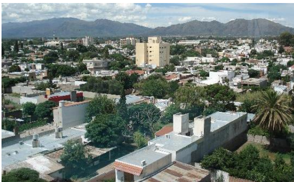
Vista panorámica de la Ciudad de San Luis y el extremo sur del cordón serrano.
